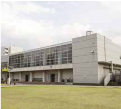
八広地域プラザ体育館
