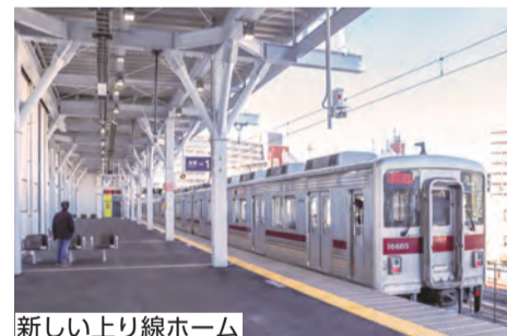
新しい上り線ホーム
