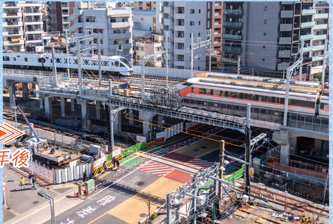
旧伊勢崎線第2号踏切部を北側上から見た様子
