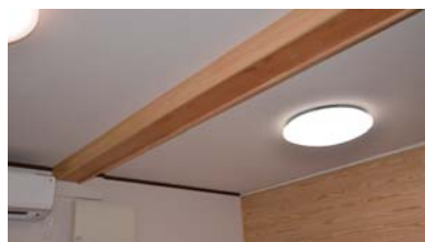
大きな空間を生み出すため、天井を少し上げた。露出した梁を天然木で囲うことで、意匠的にも工夫した。
