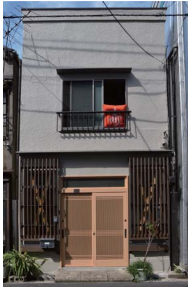
玄関引戸の両サイドを筋交い等で補強し、かつ明かりを取り込む工夫をした
