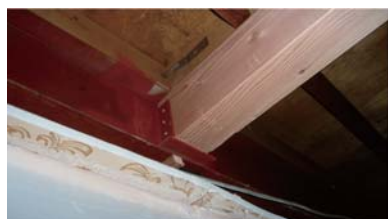
柱を取り広いスペースにするため、既存の鉄骨の梁に新たな梁を設け補強した
