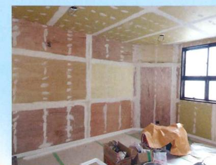
室内壁を構造用合板で補強
