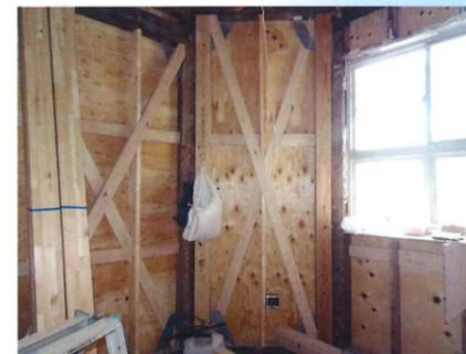
窓を撤去して筋交いで補強
