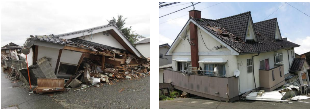
図 1-4-4 熊本地震被害状況写真
