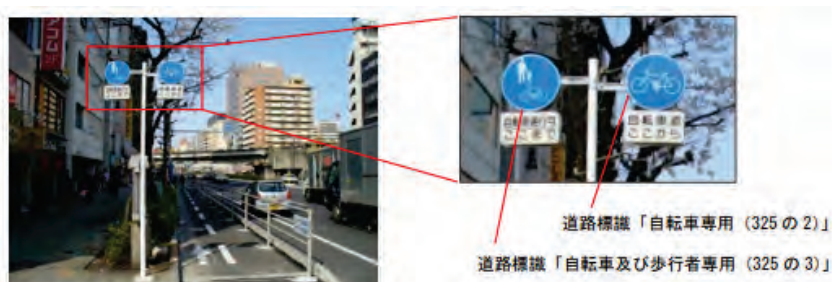
図 道路標識「自転車専用」を設置した事例
