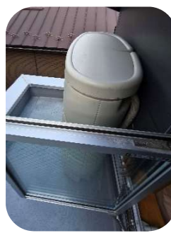
2階テラスのタンク
