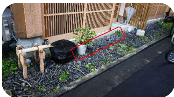
外溝の雨水貯留層（赤枠：U字溝部分）
