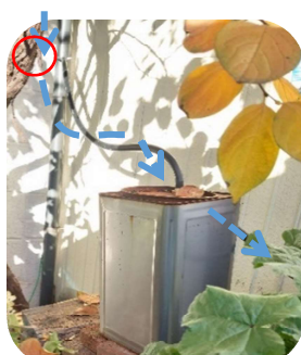
雨樋→ホース→一斗缶の接続 (赤丸は雨樋切れ目部分)
