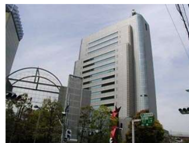
墨田区役所庁舎
