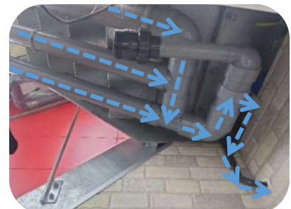
パイプ型タンクから建物内への接続
