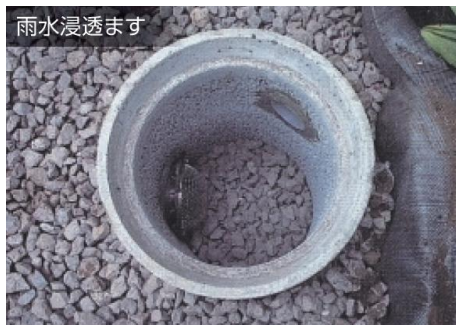
画像出典：豪雨災害からわが家を守る（東京都総合治水対策協議会）
