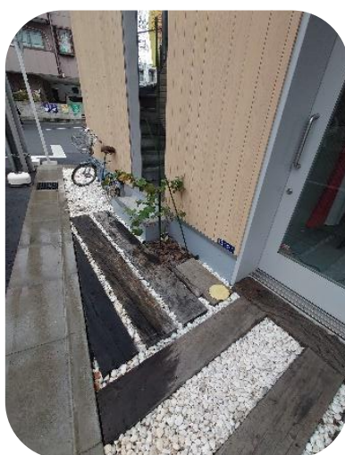
外溝の一時貯留層
