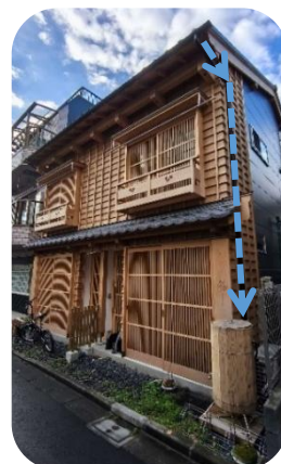
外観①（雨水の流れ・軒先雨水タンク）
