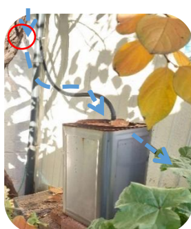
雨樋→ホース→一斗缶の接続 (赤丸は雨樋切れ目部分)
