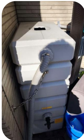
雨水タンク本体（上部開口時）
