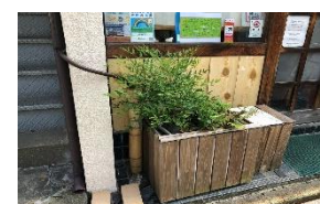
雨樋プランター
