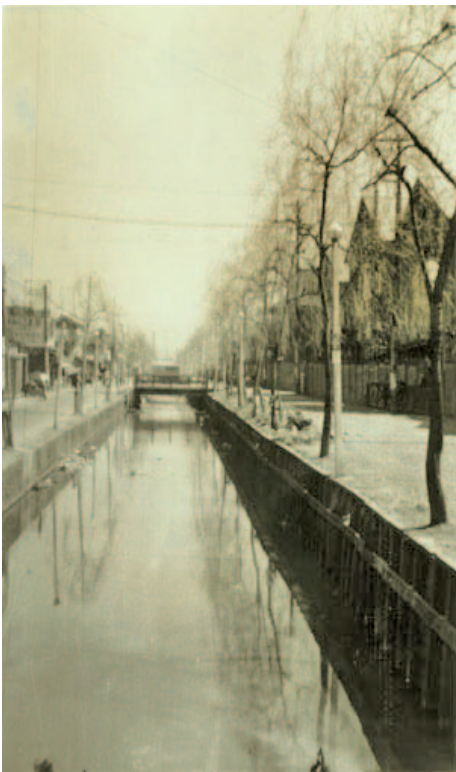
1954年頃の曳舟川旧資生堂前（京島一丁目付近）
