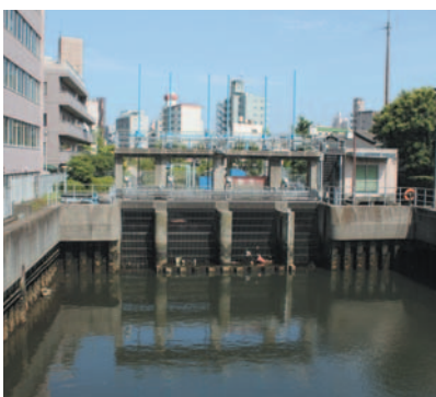
北十間川樋門
