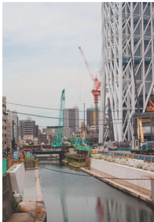
建設中の歩行者専用橋（平成22年6月）
