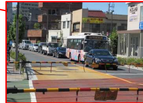
伊勢崎線第2号踏切 (桜橋通り) (平成26年5月撮影)
