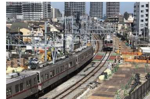
北側に移設された伊勢崎線第2号踏切等
