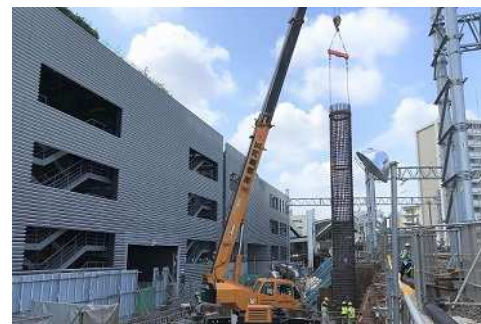
上り高架橋工事(基礎杭建込み)の様子
