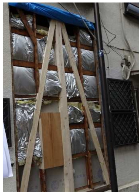
外壁筋交い補強
