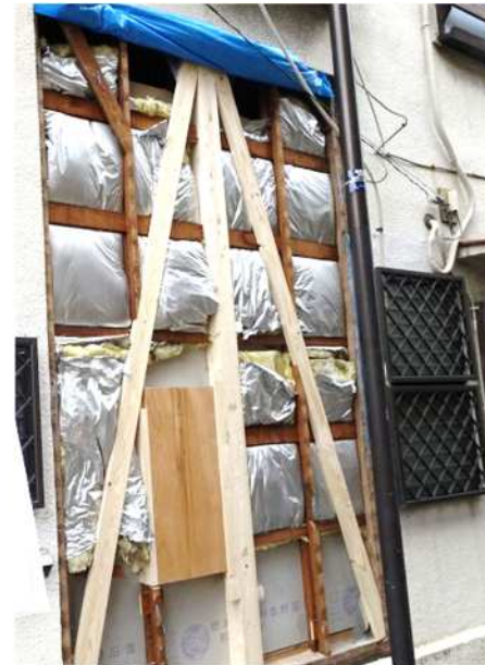
外壁筋交い補強
