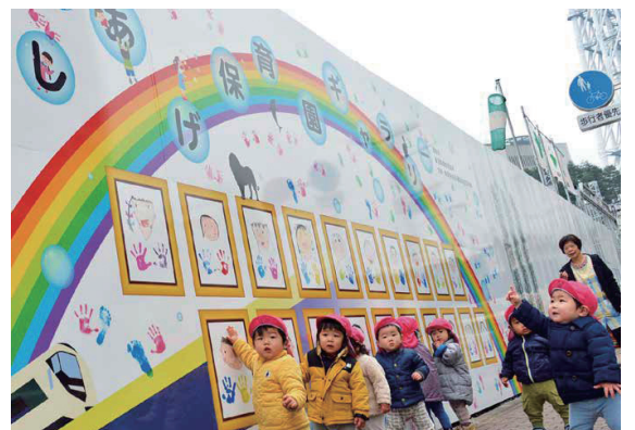
園児の絵画作品を用いた工事現場の仮囲い
