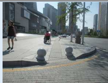
点字ブロックは日本より大きく、 歩車境界の段差はない（中国）
