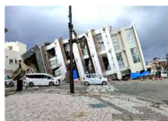
能登半島地震の被災による輪島市の状況
