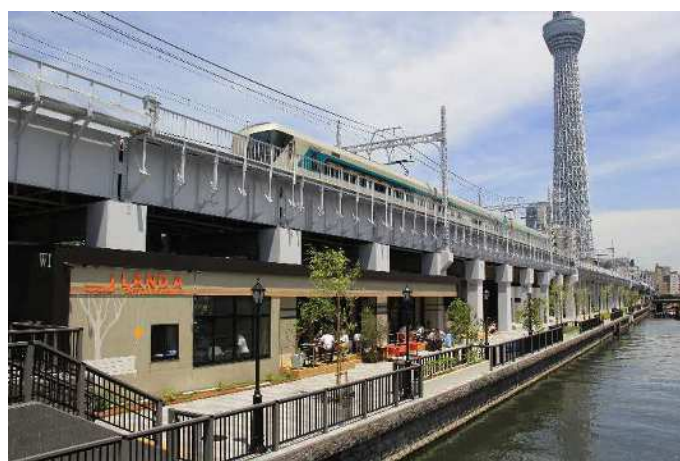
図4 北十間川テラス(源森橋～小梅橋間)
