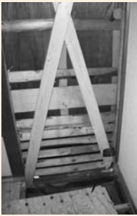
耐震改修の一例
