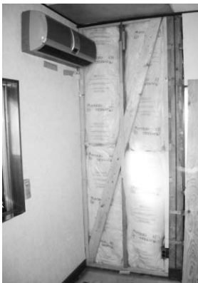
耐震改修の一例
