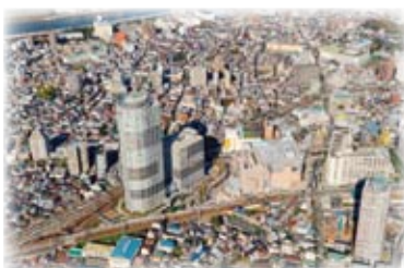
北部地域の広域拠点として商業・業務等の賑わい機能の集積をめざす曳舟エリア
