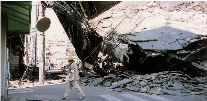
阪神・淡路大震災で倒壊し、道路を塞いだビル(「災害写真データベース」提供)
