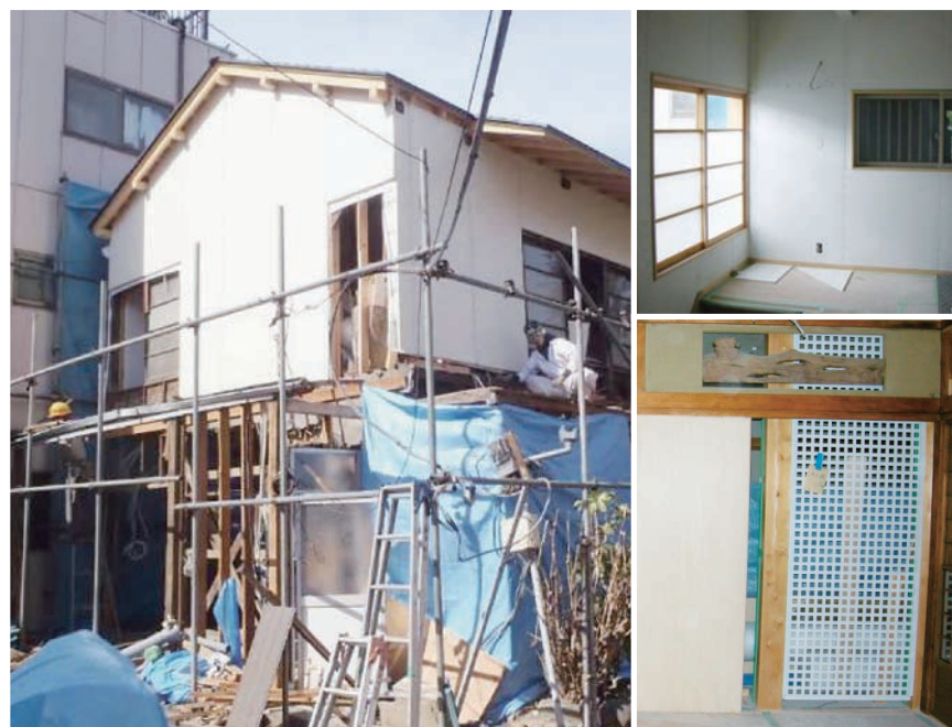
防火・耐震化改修の様子(外壁防火改修工事[左]、屋内側石膏ボード張り工事[右上]、耐力壁補強工事[右下])
