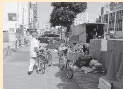
撤去作業の様子
