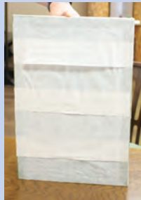
空気層を作るため、薄手の和紙をずらして貼ります。
