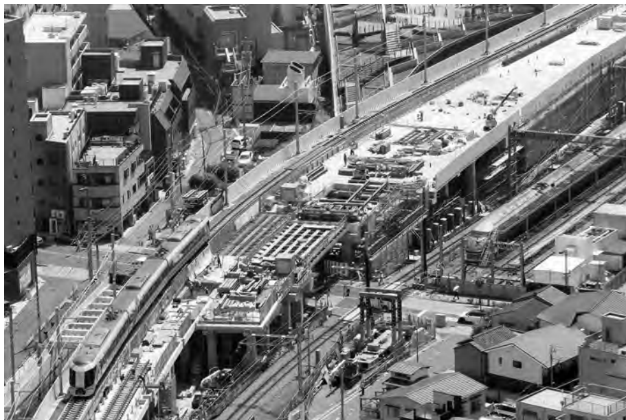
東武伊勢崎線（とうきょうスカイツリー駅付近）連続立体交差事業
