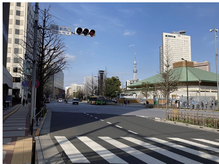
両国国技館周辺の無電柱化
