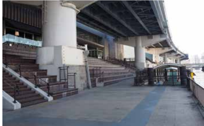
写真 20 両国リバーセンター(河川テラスの公園化:隅田川緑道公園)
