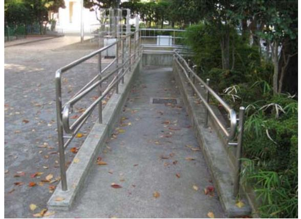
図IV-12 出入口スロープの改修例
