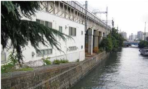
北十間川の源森橋上流。 川沿いに歩行空間は整備されていない。
