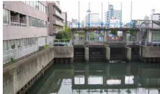
小梅橋上流にある北十間川樋門。低地部を水害から守るため、この樋門で水位調整（低下）を行っている。現在、隅田川側から船が入れるのは、この樋門までである。
