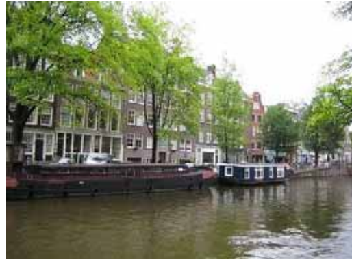
【アムステルダムの水辺景観】 建物の形態、高さ、色調などの統一感がある すばらしい街並みである。
