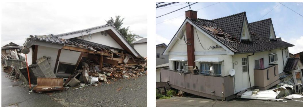
図 1-4-4 熊本地震被害状況写真
