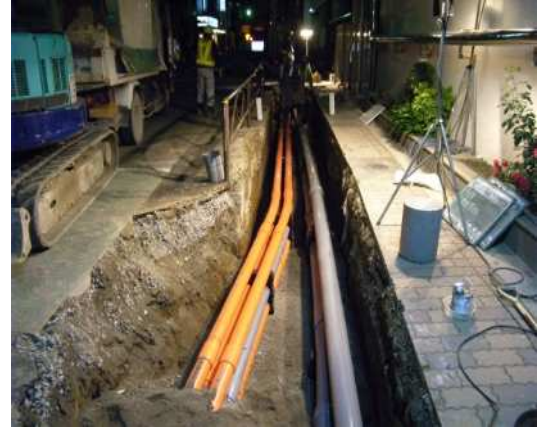
写真 夜間施工の様子（本体工事）
