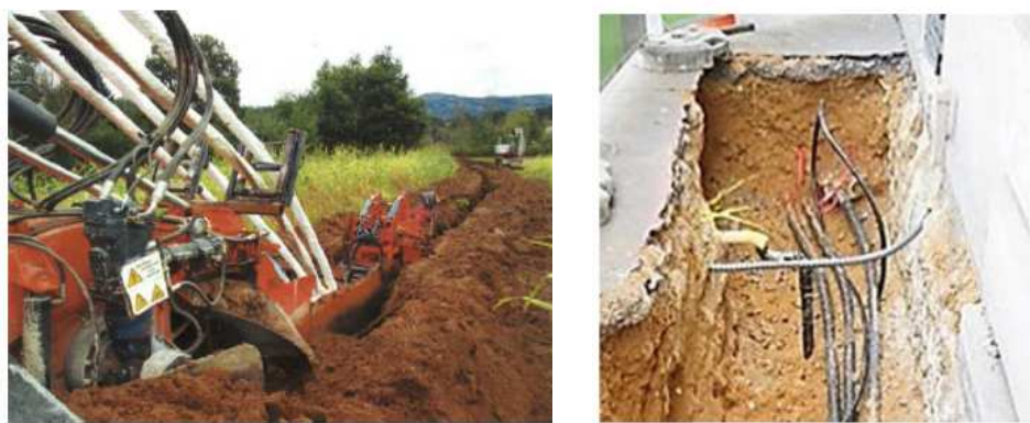
写真 海外での直接埋設方式施工状況
