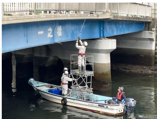
写真 3-1. 点検中の一之橋
