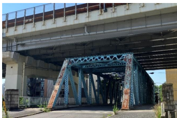
写真 1-1. 撤去予定の松本橋（橋年 96 年）
