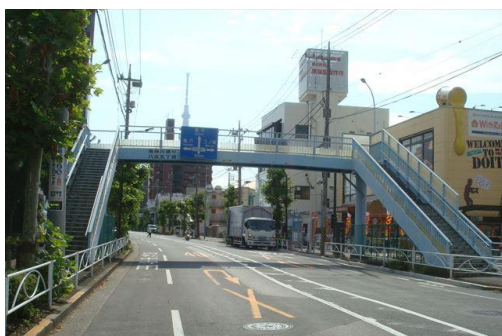
写真 4-1. 撤去予定の八広歩道橋
