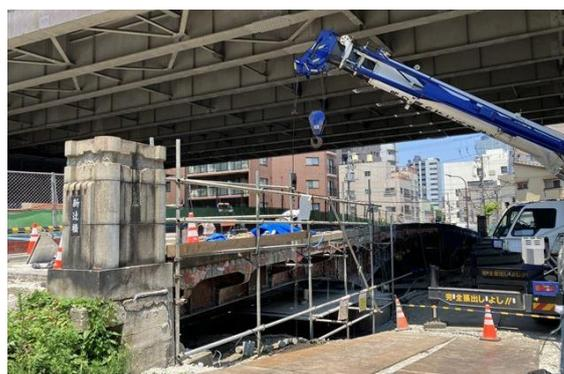
写真 4-2. 撤去工事中の新辻橋
