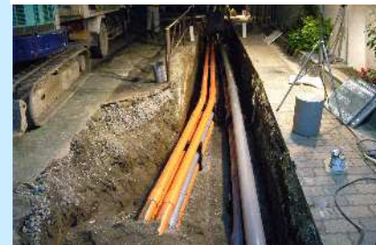
既存埋設物を移設し施工
