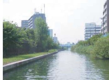
護岸未整備箇所
