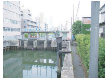
北十間川樋門
