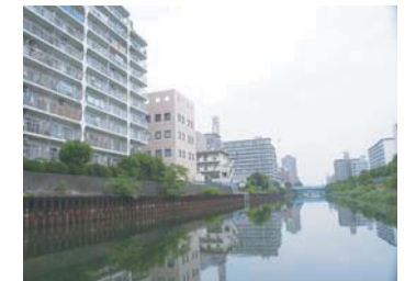
護岸未整備箇所
