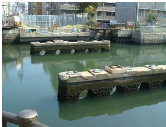
写真 4-2. 架替え工事中の南辻橋
