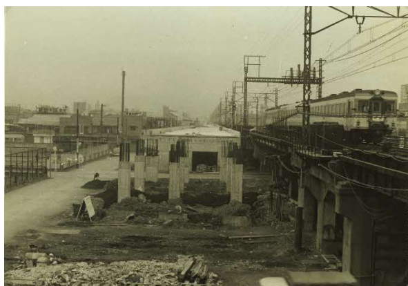
▶ 総武線複々線化工事（亀沢二丁目）（1966年）
