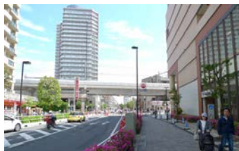
曳舟駅周辺の再開発と道路拡幅
