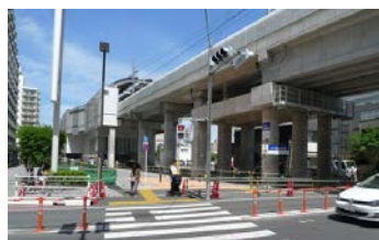
京成線の連続立体交差事業
