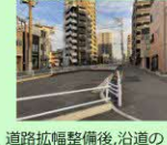
道路拡幅整備後、沿道の 有効利用がなされていない。
