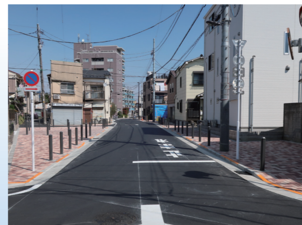
優先整備路線4号線側から(南側から北方向)
