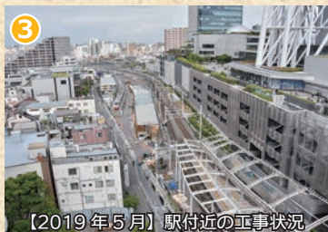
【2019年5月】駅付近の工事状況
