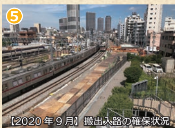
【2020年9月】搬出入路の確保状況
