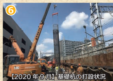
【2020年9月】基礎杭の打設状況
