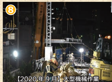
【2020年9月】大型機械作業
