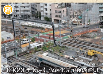
【2020年6月】仮線化完了後の踏切
