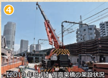
【2019年8月】仮高架橋の架設状況
