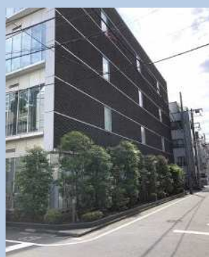
緑化による潤いのある空間
