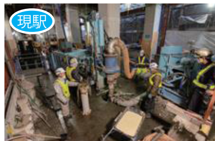
【2021年1月】現駅舎付近の基礎工事 撮影/東武鉄道
