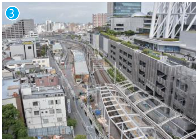
【2019年5月】駅付近の工事状況 撮影/東武鉄道
