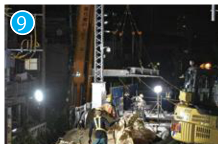
【2020年9月】夜間の大型機械作業 撮影/東武鉄道
