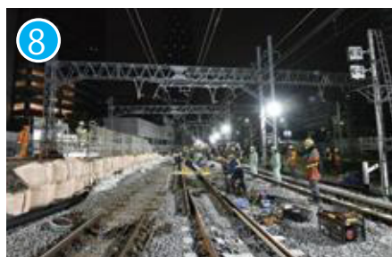
【2020年3月】線路切替人力作業 撮影/東武鉄道
