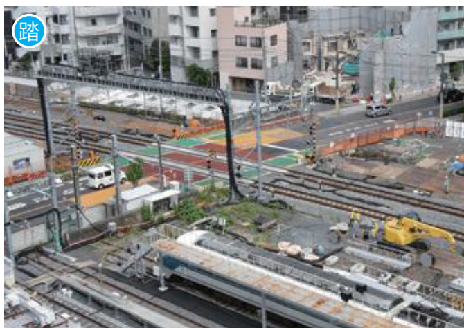
【2020年6月】仮線化完了後の踏切 撮影/東武鉄道
