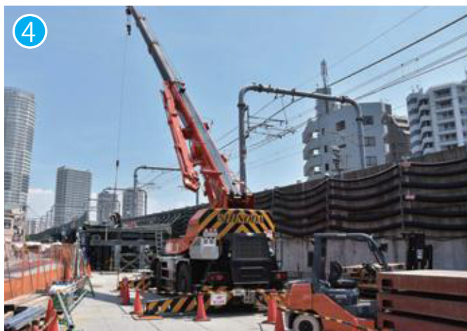
【2019年8月】仮高架橋の架設状況 撮影/東武鉄道
