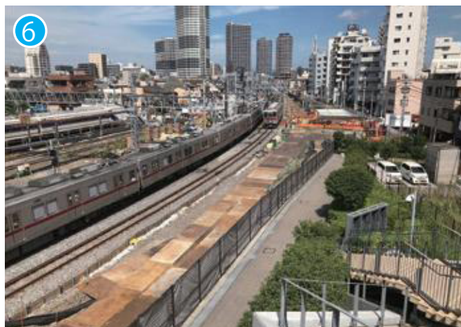
【2020年9月】搬出入路の確保状況 撮影/東武鉄道
