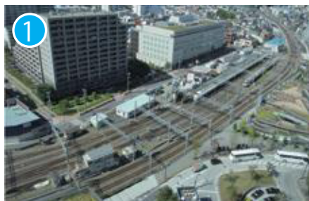
【2016年5月】留置線付近の様子 撮影/東武鉄道
