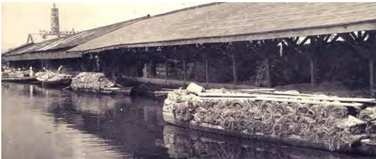
当時の浅草駅（現とうきょうスカイツリー駅）に設けられたドック※ 東武博物館提供/撮影年：不明（昭和初期頃）
