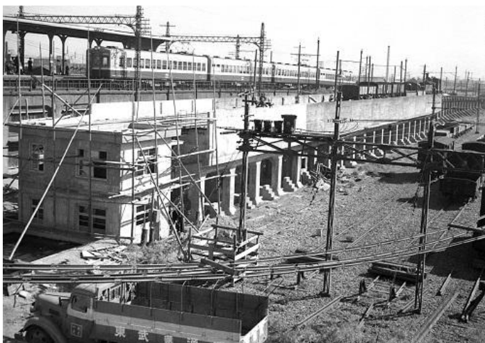
ホッパー線の延長工事が始まった業平橋駅（現とうきょうスカイツリー駅）構内 ～交通東武より～ 東武博物館提供/撮影年：1957(昭和32)年
