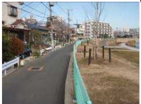
堤防整備（平成18年頃）
