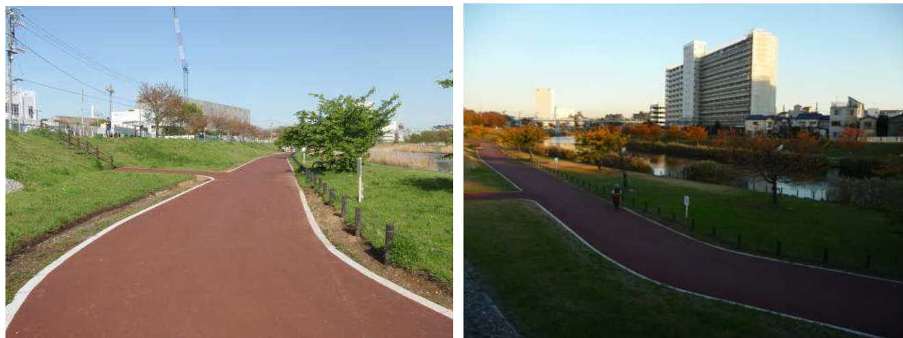
幅員 4 m、カラーアスファルト舗装
