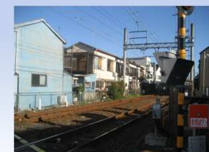
旧十間橋通駅 遺構(推定)
