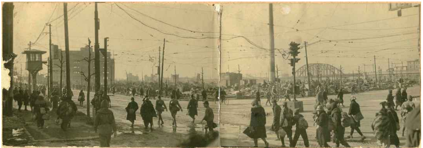
両国駅近くの京葉道路、左奥が両国橋。右奥に総武線の隅田川橋梁が写っている 撮影：工藤哲朗
