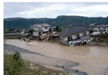
本津川の氾濫後の状況(香川県高松市鬼無町) 出典：国土交通省ホームページ「水害レポート2004」
